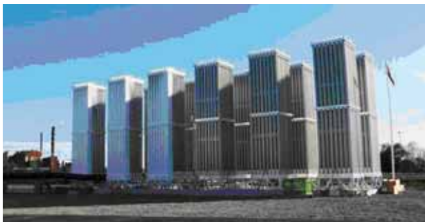
Obrázek 8: Vzduchové odpařovače
