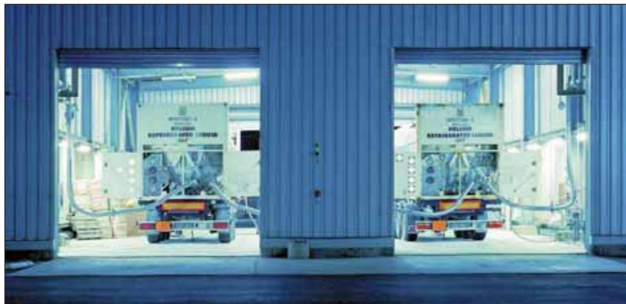
Obrázek 11: Plnění cisteren kapalným heliem
