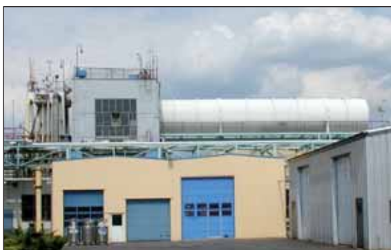
Obrázek 4: Budova zkapaňovače helia a skladovací tank 500 m 3 v Odolanowě
