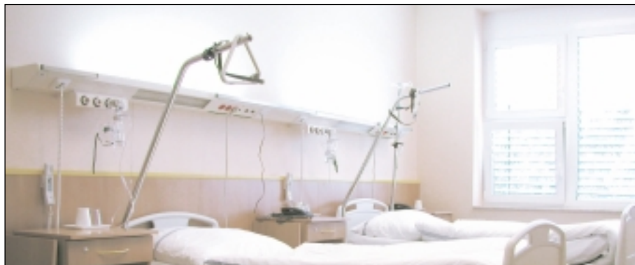
Obr. č. 7 – lůžková rampa
