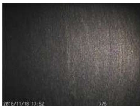
Obrázek 12: Vnitřek tlakové láhve J62.1
