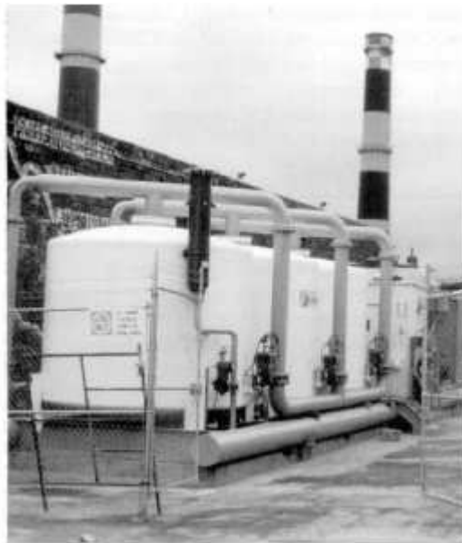
Obrázek 4 – Generátor kyslíku PSA se třemi loži
