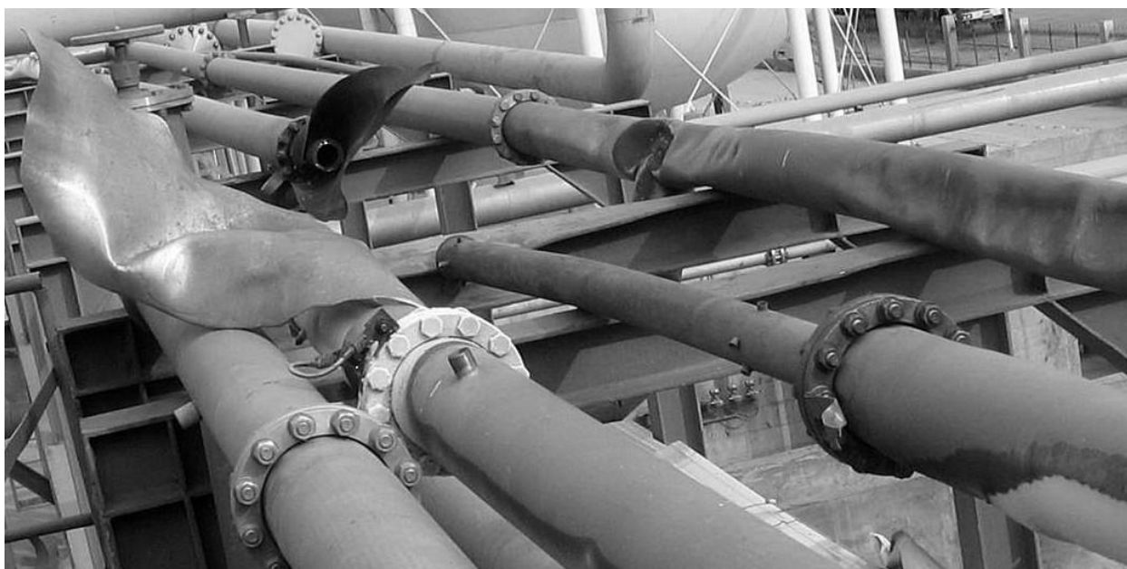
Obrázek 1 – Situace na vakuem izolovaném plášťovém potrubí LOX po nehodě
