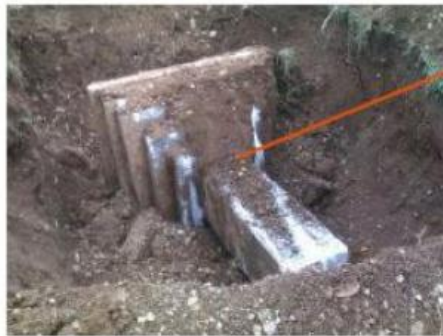
Elektrický stožár, který má být odstraněn
